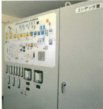
●中央監視室 全施設の運転を監視します。
