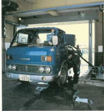
●搬入車床 生し尿、浄化槽汚泥の受入れをします。
