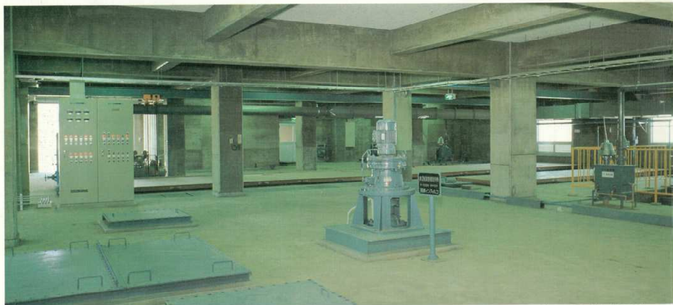
●処理棟 処理棟には第1攪拌槽(第1脱窒素槽)、第1曝気槽(硝酸化槽)、第2攪拌槽(第2脱窒素槽)、第2曝気槽(再曝気槽)、沈殿池、三次処理設備が1体に組まれており、本施設の心臓部であります。
